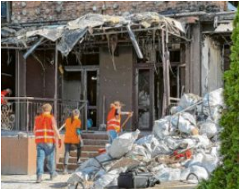
Freiwillige Helfer der Hilfsorganisation Razom räumen Schutt aus beschädigten Wohnungen.
